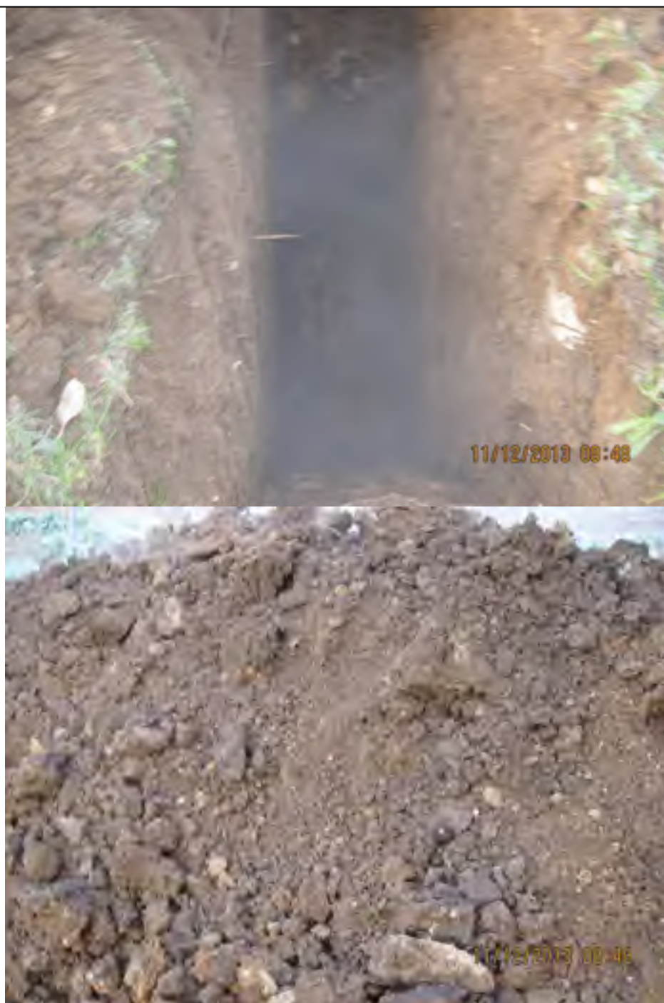
Fig. 4: lo scavo n. 1 e il terreno di risulta
