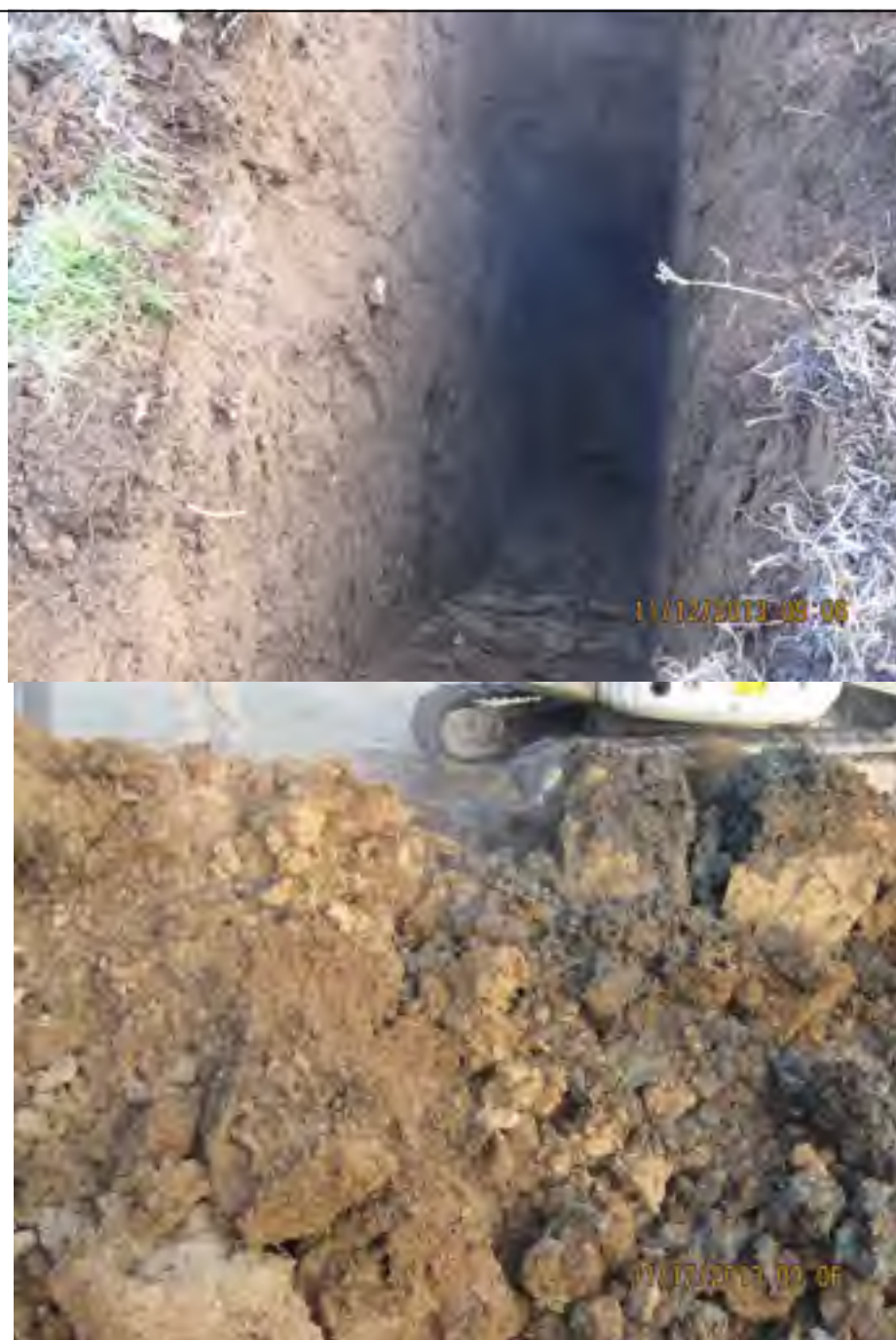
Fig. 5: lo scavo n. 2 e il terreno di risulta
